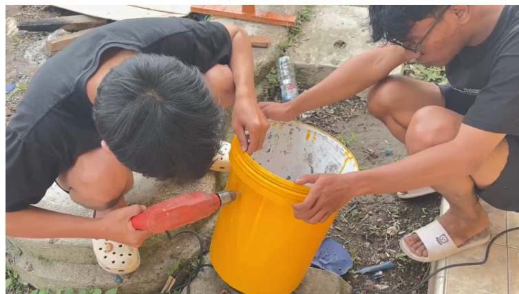
Gambar 4. Proses pengeboran wadah untuk pemasangan mur pada rangka kayu penyangga
