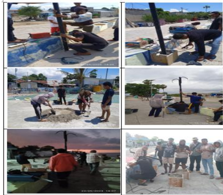
Gambar 3 Pemasangan Tiang Lampu (Sumber: Penulis, 2024)
